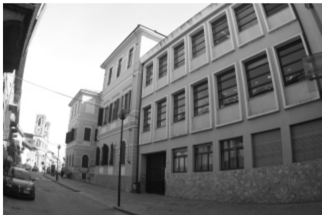
Scuola primaria di Via Guibert
