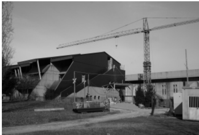
I lavori alla scuola primaria di viale Bona
